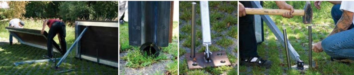
Bei natürlich gewachsenem Untergrund wird die Wandabstützung mit Stahlbolzen im Boden gesichert.
